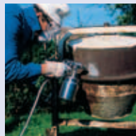
Sandstrahlen 50-500 l/min, 5-6 bar
